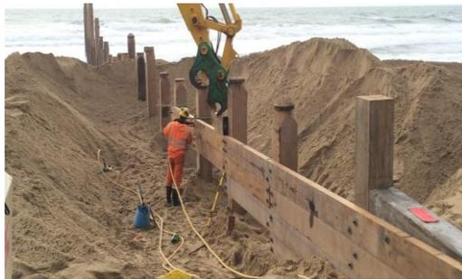
**Figura 65** – Exemplo de instalação de espigão com madeira certificada em Bournemouth – Reino Unido.
