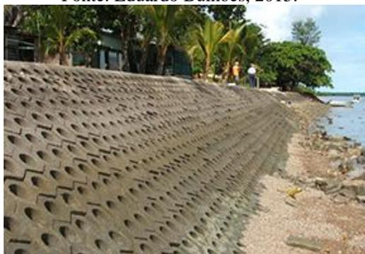
**Figura 41** - Exemplo de intervenção fixa do tipo paredão (*seawall*) – Staten Island – Nova Iorque – NY – EUA.
