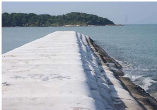
**Figura 39** – intervenção fixa (espigão) construída com geotêxtis (*geobags*) – Buzios – RJ.
