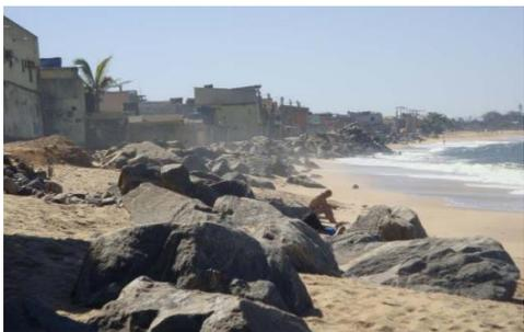
**Figura 34** - Exemplo de tentativa de contenção da erosão costeira com enrocamento em área urbana em Macaé, RJ.
