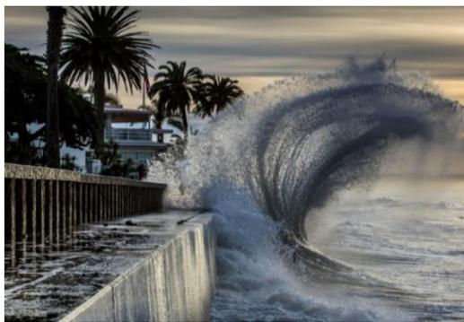
**Figura 42** – Exemplo de intervenção fixa do tipo mureta (*bulkhead*) defletindo as ondas – Miami Beach – FL – EUA.
